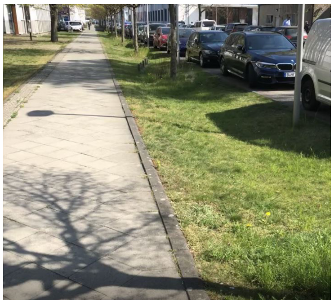
Abb. 62 Versickerungsmulden in Berlin Adlershof (Foto bgmr, 2020)
