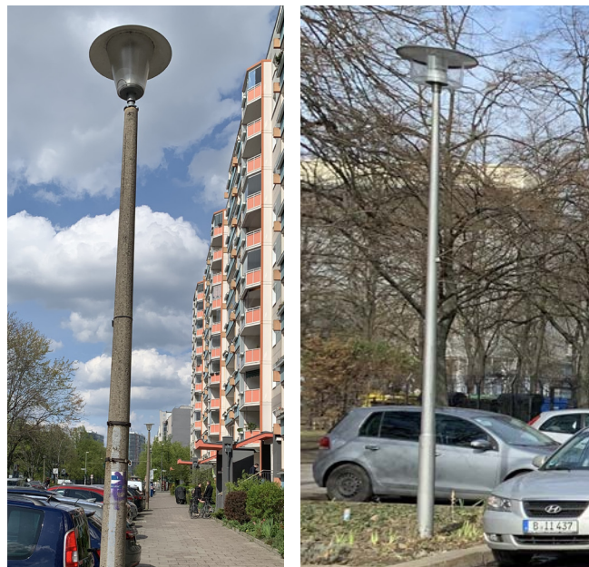
Abb. 42 Beleuchtung in der Michaelkirchstraße
