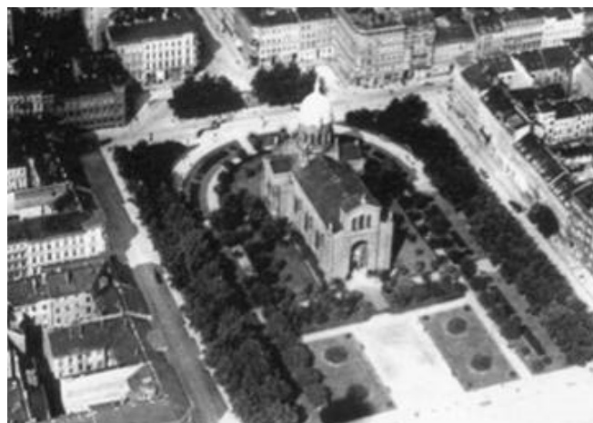
Abb. 6 Luftbild des Michaelkirchplatzes um 1919; Quelle: http://www.foerderverein-stmichael-kirche.de
