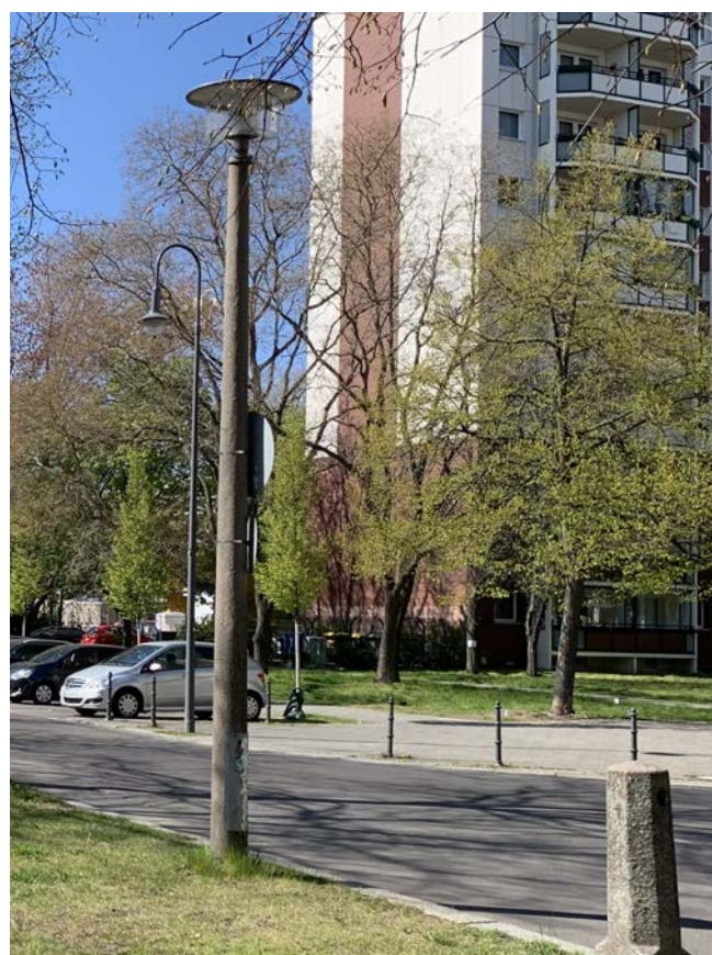
Abb. 43 Michaelkirchplatz: historische Leuchten, DDR Standardleuchte
